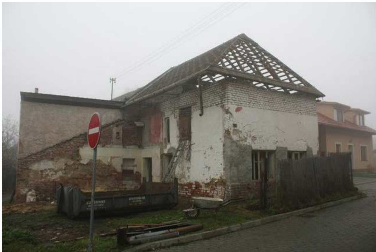
Na podzim byl zbořen dům č.p. 199 na ul. Poděbradova
