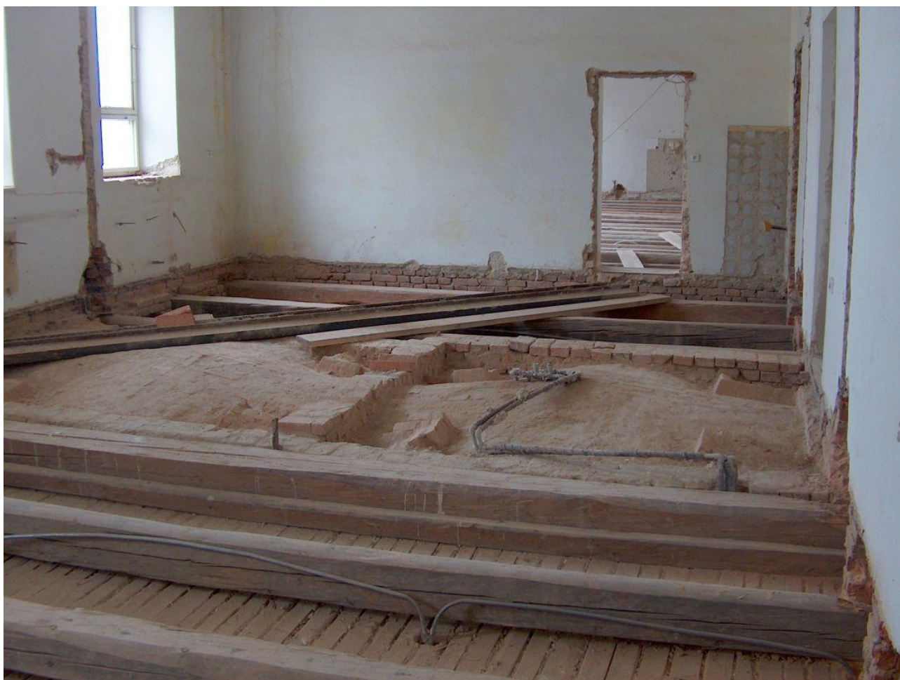
V roce 2008 byla zahájena rekonstrukce kláštera, snímek podlah nad vchodem
